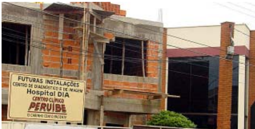
Obras do Centro de Diagnóstico de Imagem Hospital Dia
